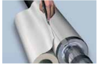
3. kép. Ragasztószalag méretre vágása
