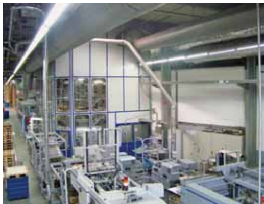
A gép a hangszigetelő fal mögött Meldorfban
